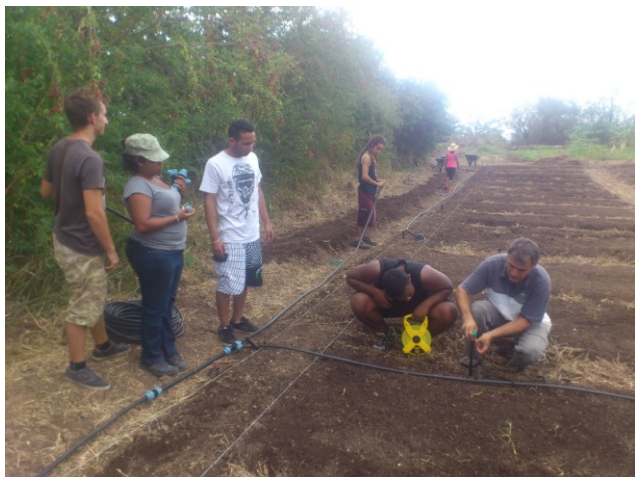
Installation de l'irrigation par les BTS GEMEAU
